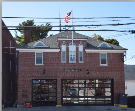
Estação da Hancock Street 54 Hancock Street
