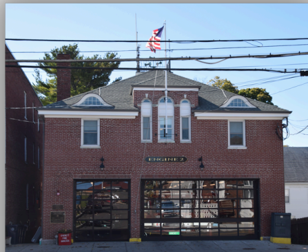
Estação da Hancock Street 54 Hancock Street
