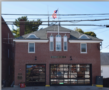
Estación de Hancock Street 54 Hancock Street
